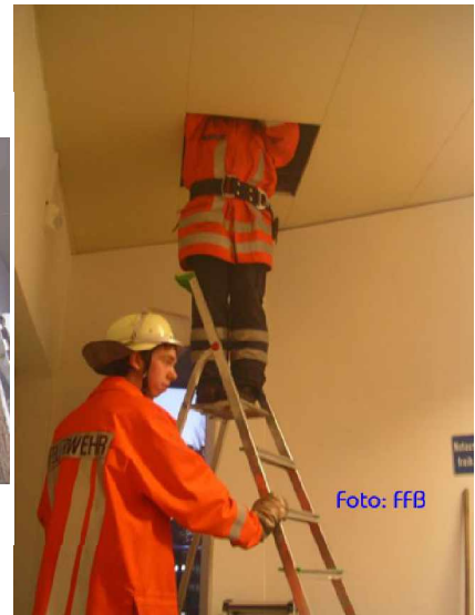
Überprüfung der Verkleidung
